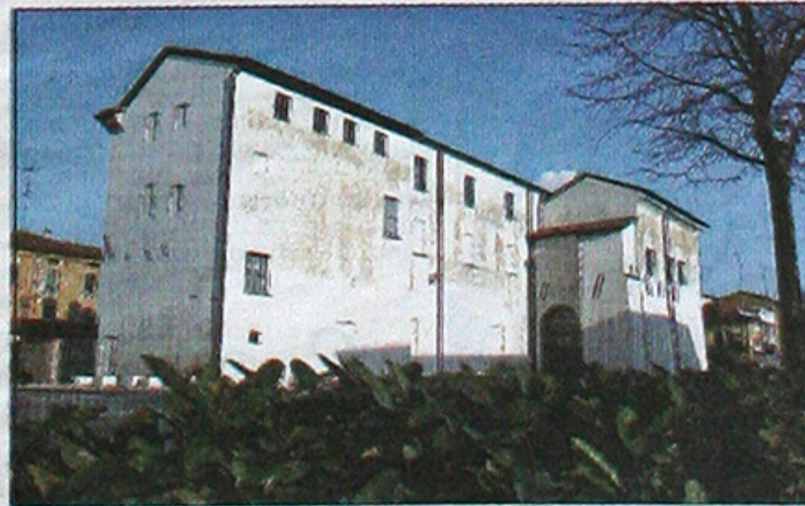
La facciata sud dopo l'intervento di restauro
